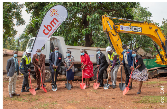
↑ Eine neue Augenklinik entsteht – dreistöckig, mit modernem Operationstrakt. Am 1. Dezember 2021 war Spatenstich.
